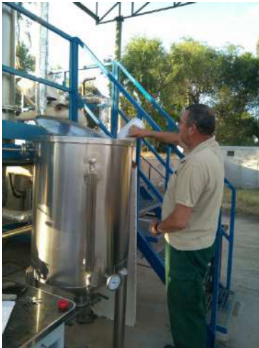
Detalle de la alimentación del tanque de disolvente (etanol 99%).
